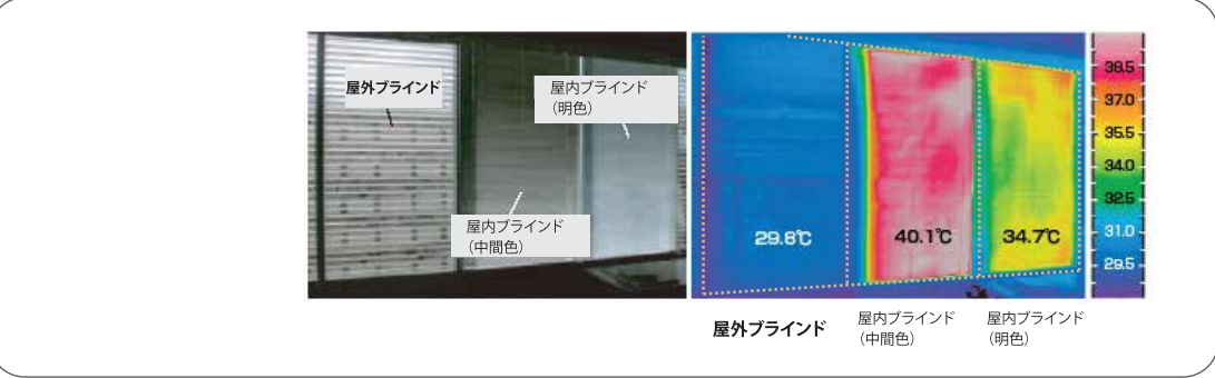
屋内＆屋外ブラインドを設置した場合の窓表面温度の比較
