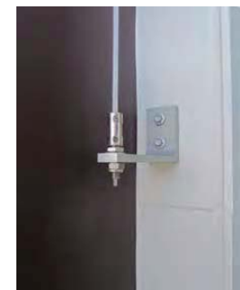
L型ターミネーションブラケットの取付例
